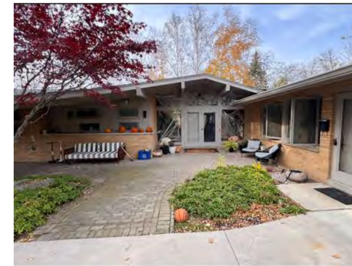
7 EXISTING EXTERIOR - EAST VIEW SCALE: N.T.S.
