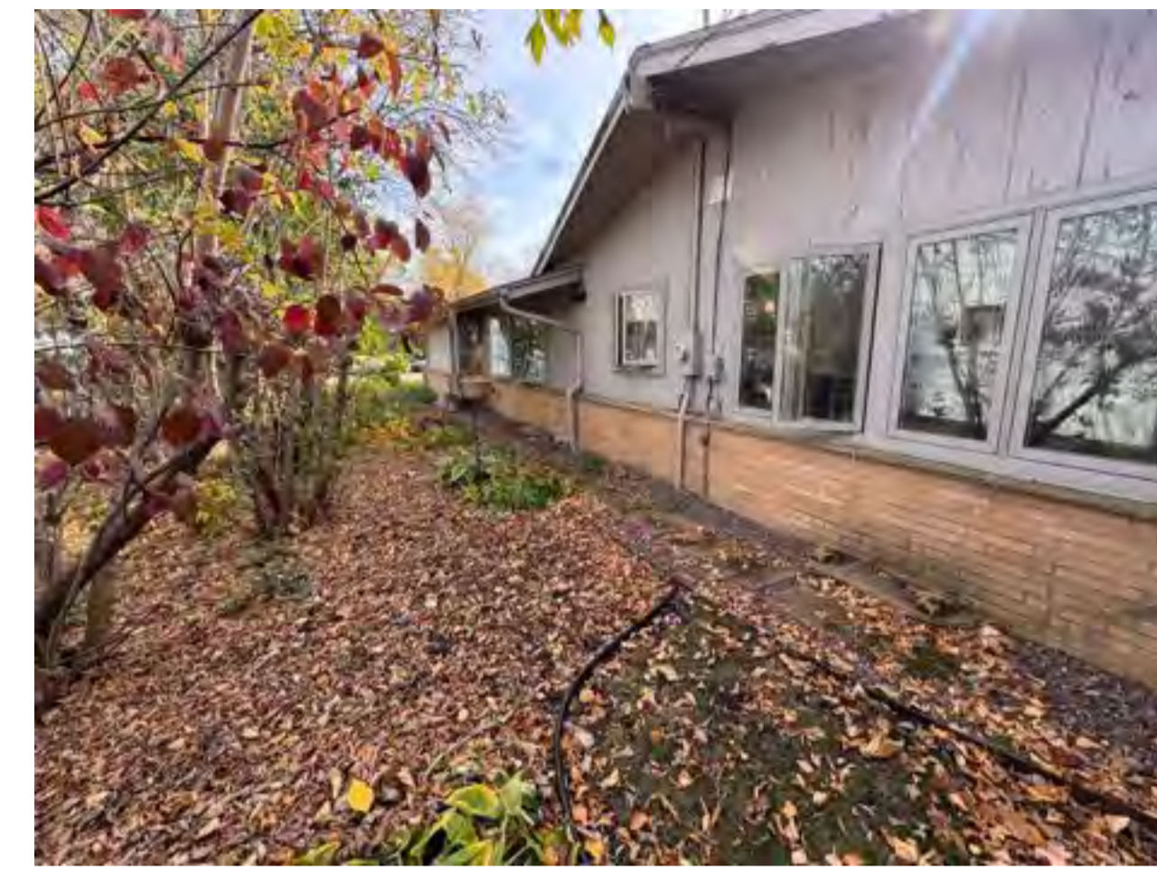
3 EXISTING EXTERIOR - NORTH VIEW SCALE: N.T.S.
