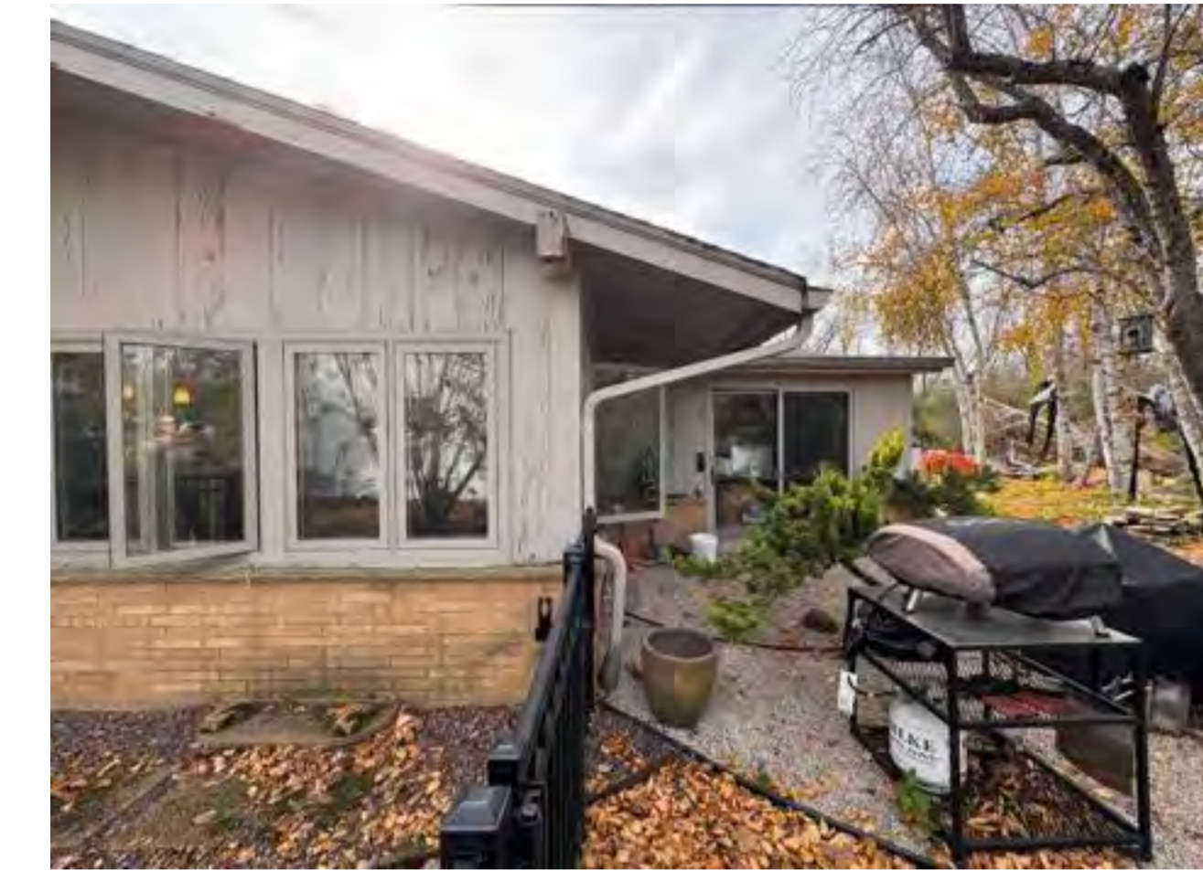
4 EXISTING EXTERIOR - NORTH VIEW SCALE: N.T.S.
