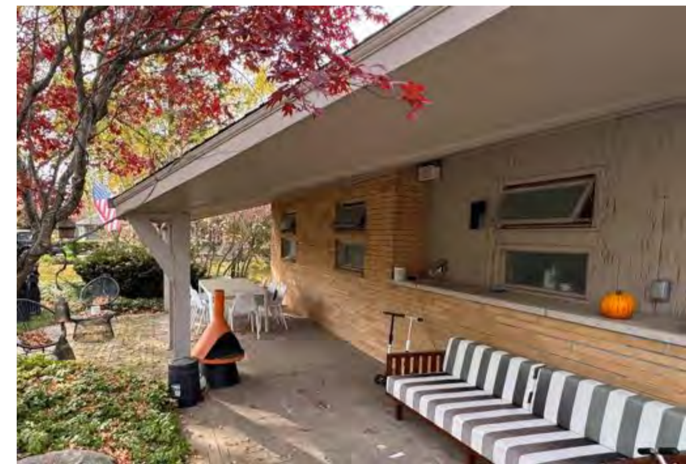
6 EXISTING EXTERIOR - EAST VIEW SCALE: N.T.S.
