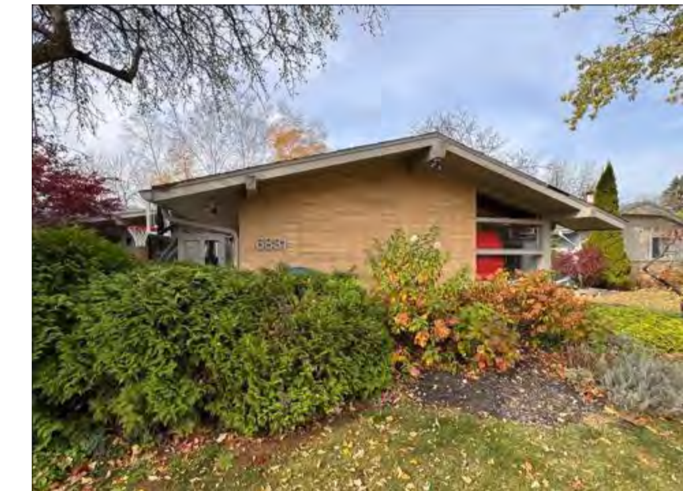
8 EXISTING EXTERIOR - EAST VIEW SCALE: N.T.S.
