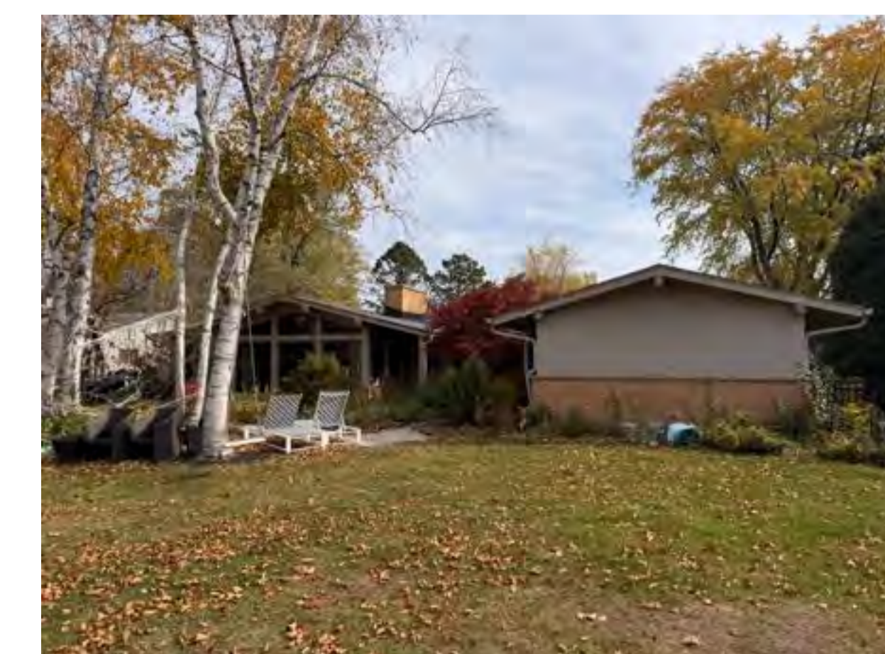
12 EXISTING EXTERIOR - WEST VIEW SCALE: N.T.S.
