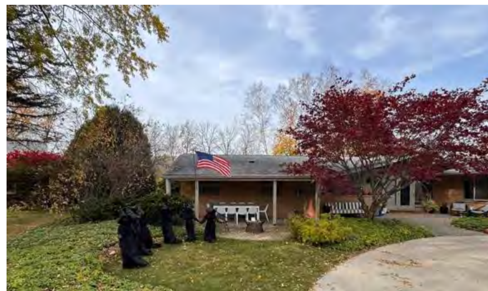
5 EXISTING EXTERIOR - EAST VIEW SCALE: N.T.S.
