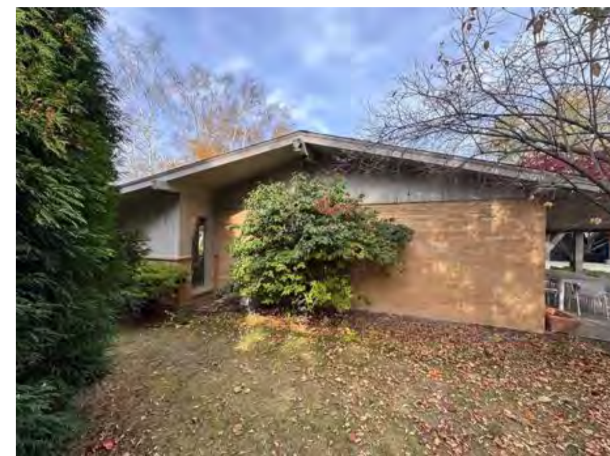
10 EXISTING EXTERIOR - SOUTH VIEW SCALE: N.T.S.
