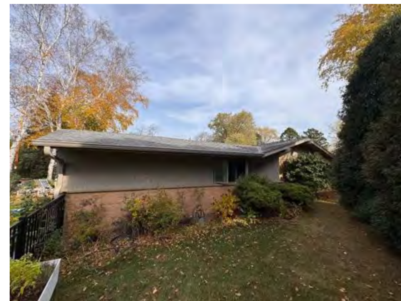
9 EXISTING EXTERIOR - SOUTH VIEW SCALE: N.T.S.
