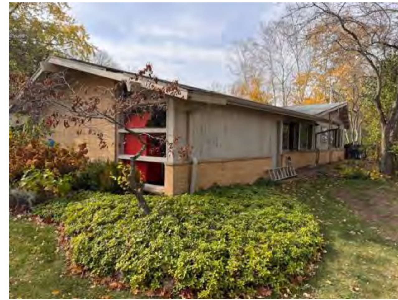
2 EXISTING EXTERIOR - NORTH VIEW SCALE: N.T.S.
