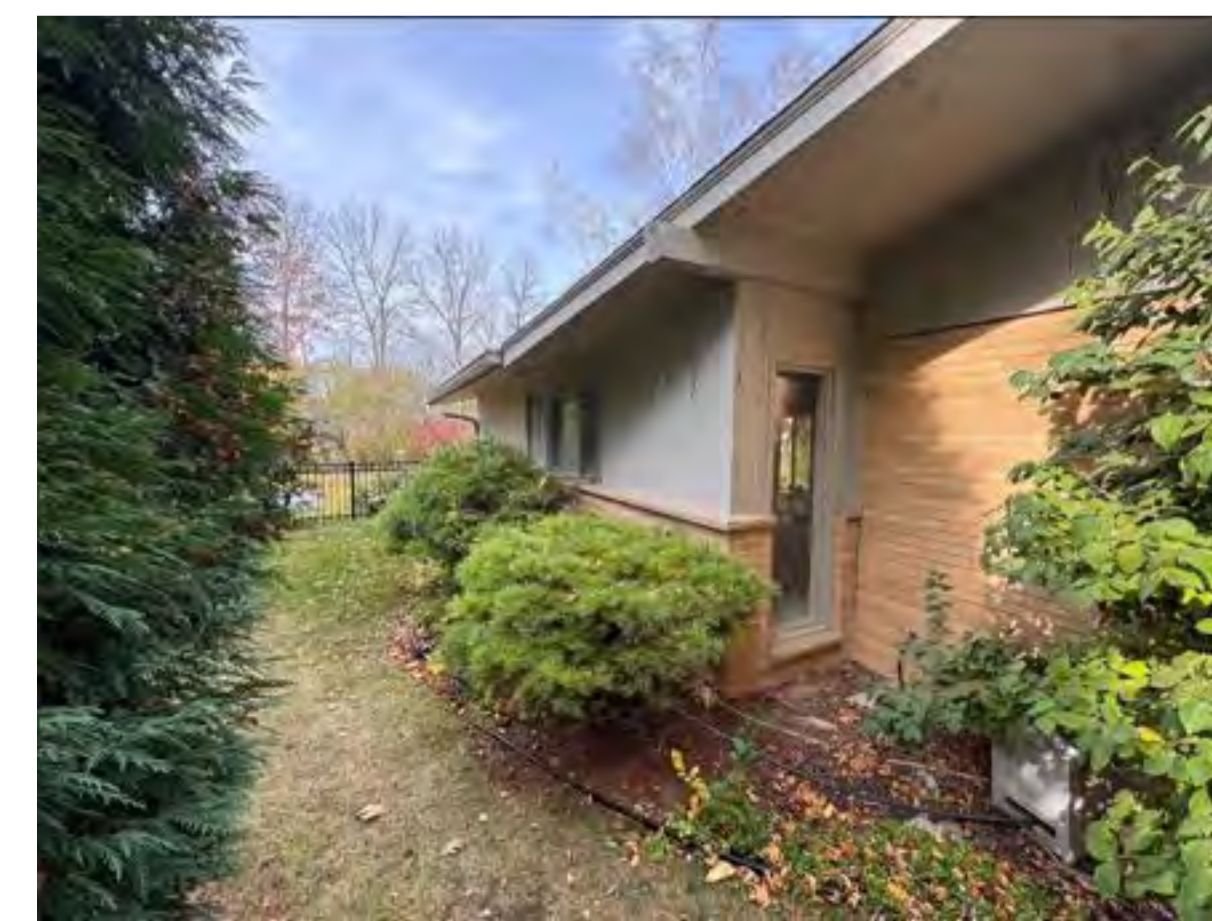
11 EXISTING EXTERIOR - SOUTH VIEW SCALE: N.T.S.
