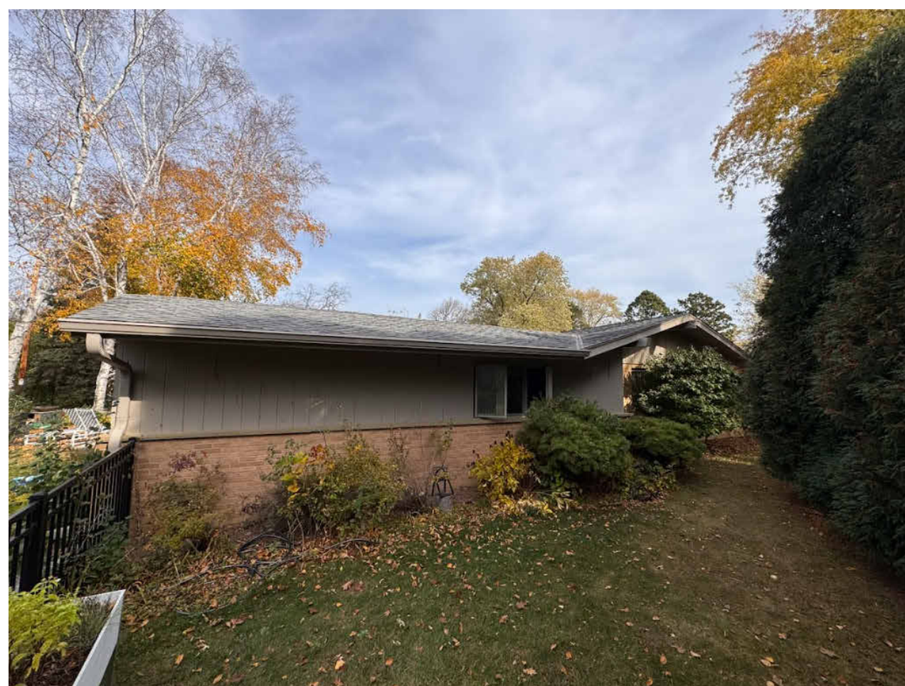
9 EXISTING EXTERIOR - SOUTH VIEW SCALE: N.T.S.
