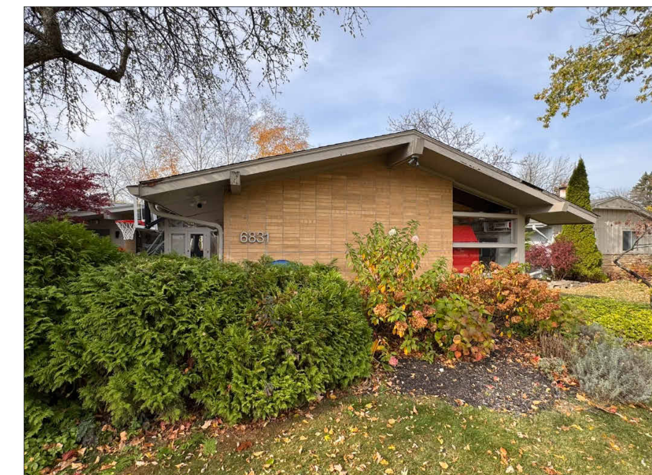
8 EXISTING EXTERIOR - EAST VIEW SCALE: N.T.S.
