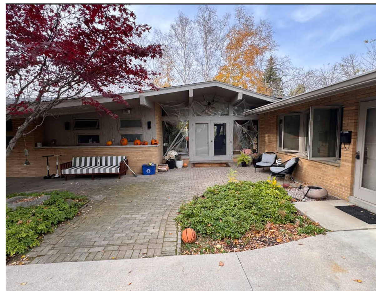
7 EXISTING EXTERIOR - EAST VIEW SCALE: N.T.S.
