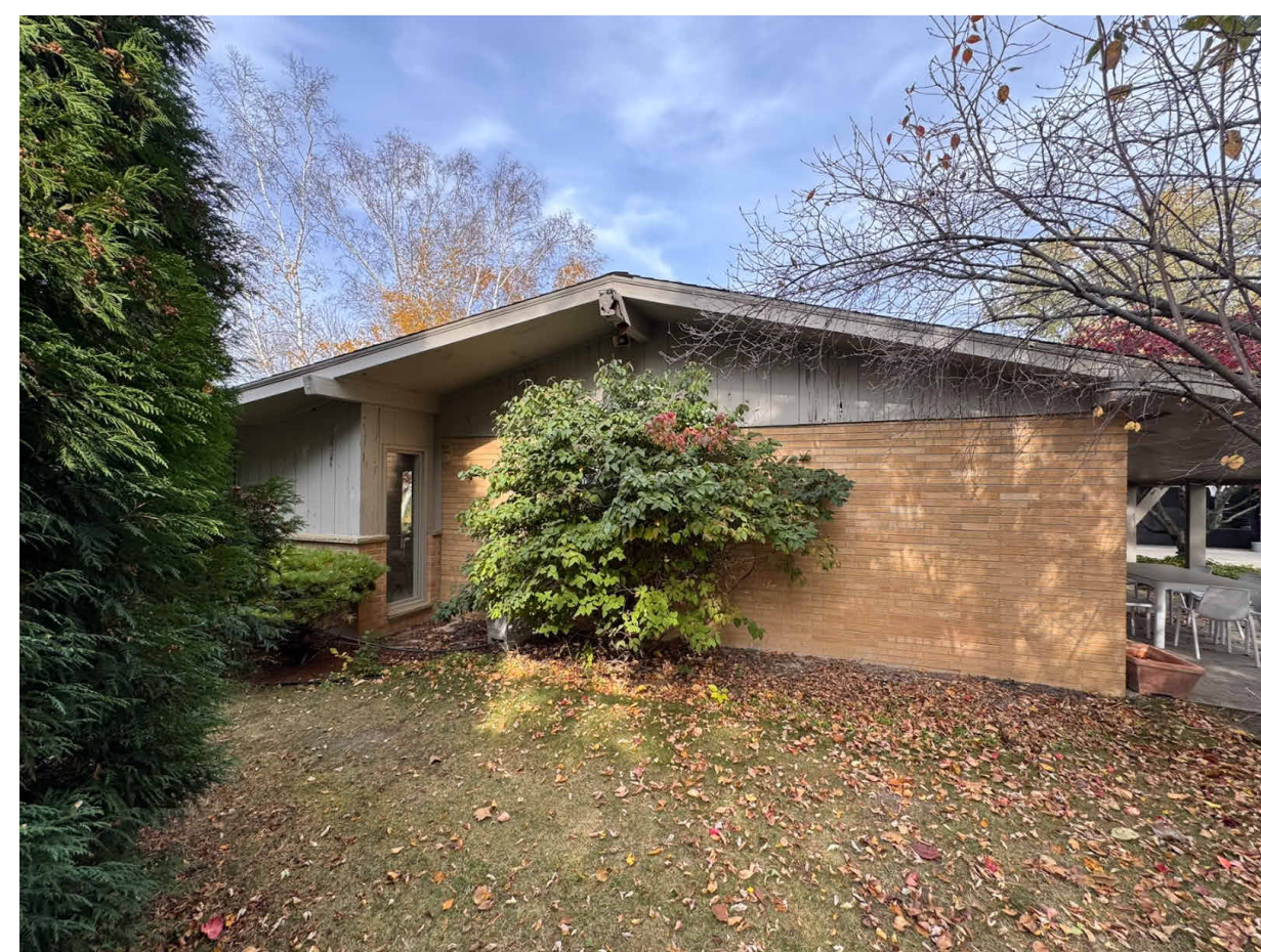
10 EXISTING EXTERIOR - SOUTH VIEW SCALE: N.T.S.
