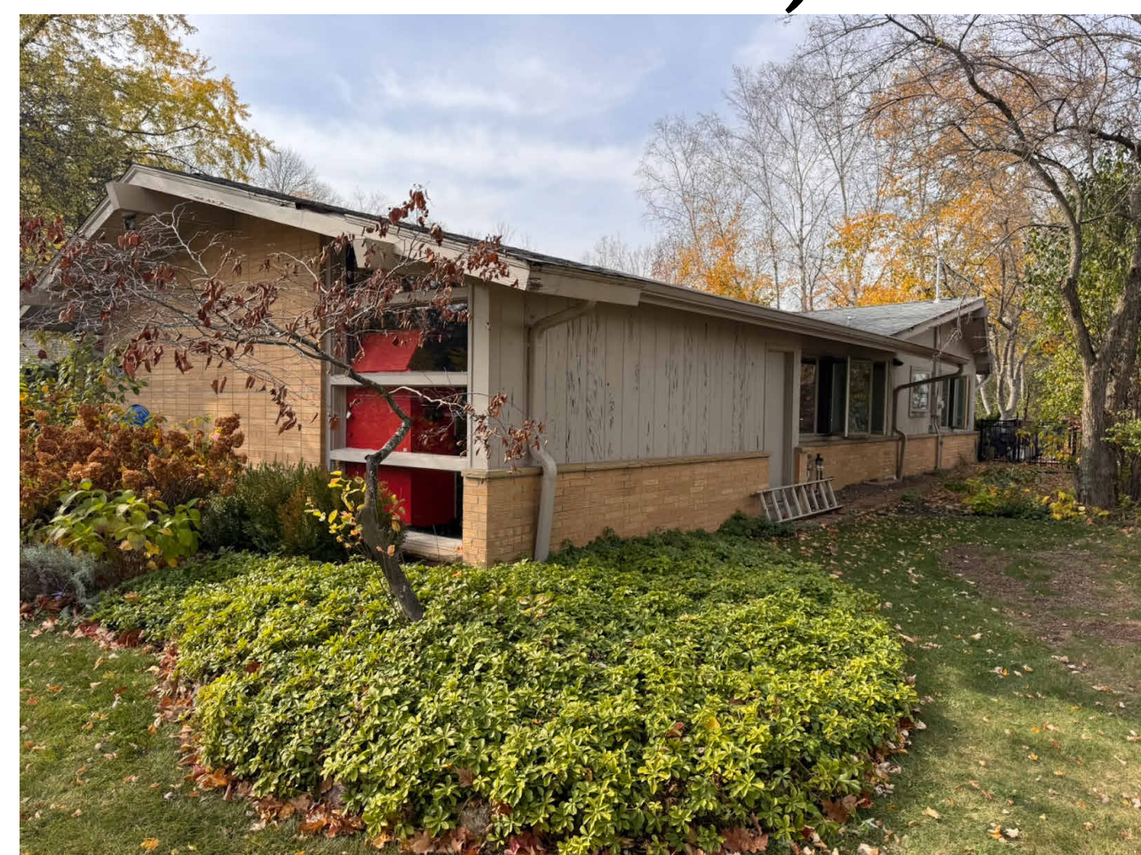
2 EXISTING EXTERIOR - NORTH VIEW SCALE: N.T.S.
