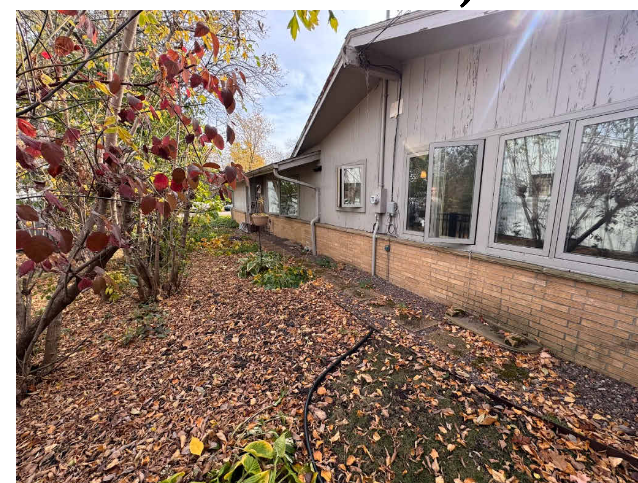
3 EXISTING EXTERIOR - NORTH VIEW SCALE: N.T.S.
