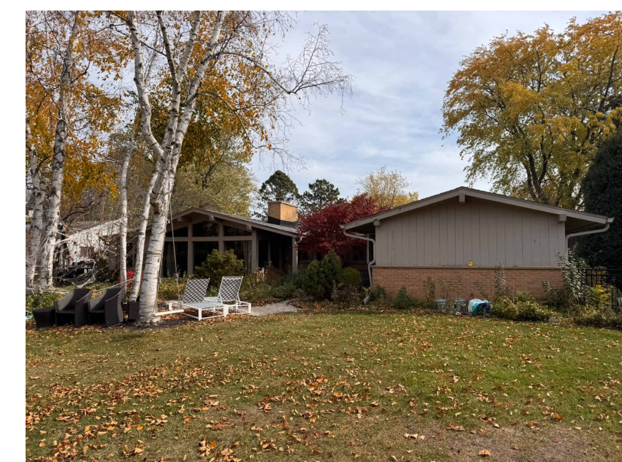
12 EXISTING EXTERIOR - WEST VIEW SCALE: N.T.S.
