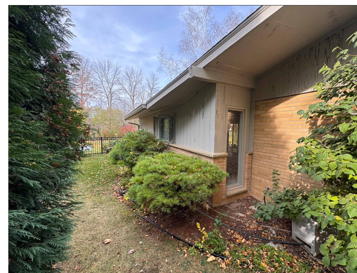
11 EXISTING EXTERIOR - SOUTH VIEW SCALE: N.T.S.
