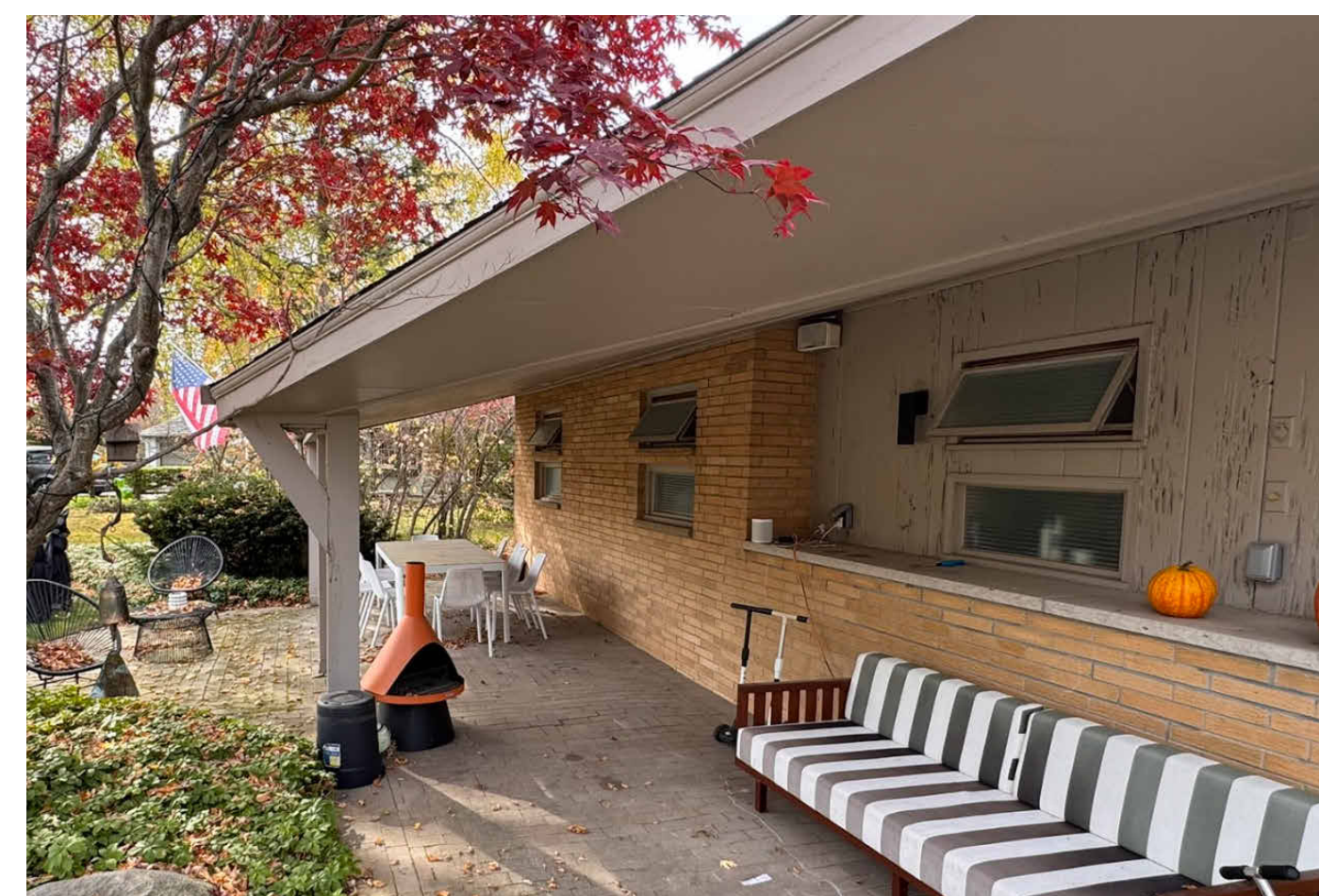
6 EXISTING EXTERIOR - EAST VIEW SCALE: N.T.S.
